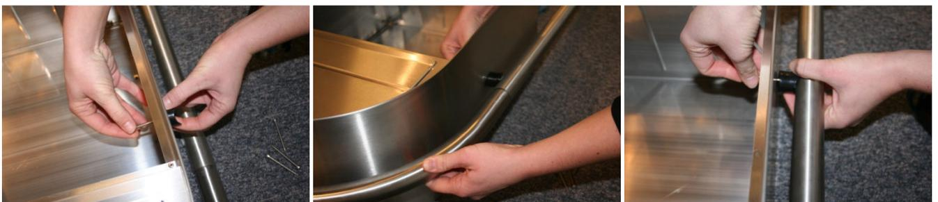
6. Serrer à fond les vis en veillant à aligner le support. Le support devrait être parallèle au bord avant de la boîte aux lettres.
